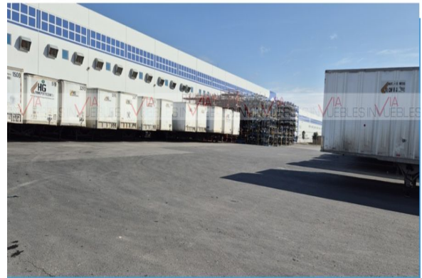
VISTA INTERIOR AFUERA DE OFICINAS
