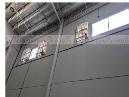
VISTA EQUIPOS DE EXTRACCIÓN DE AIRE
